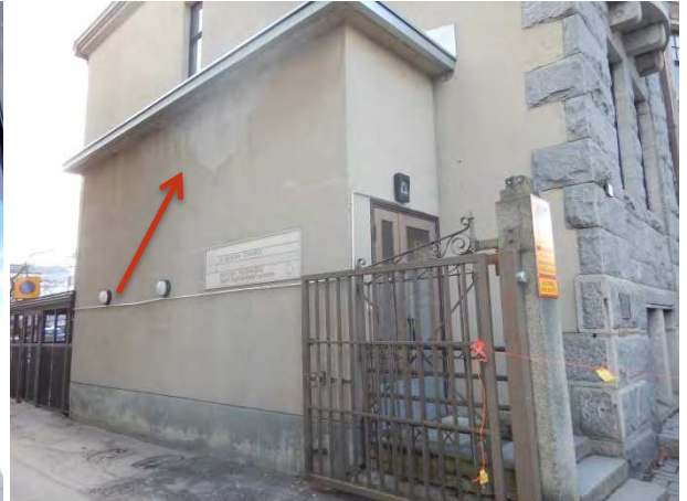
Kuva 3.11 Julkisivun itäpääty (B-porras)
