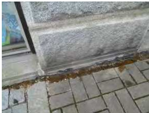
Seinän vierillä on pääosin kiveys tai asvaltti, rakoa on tiivistetty.
