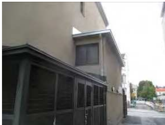
Pääty Carlsonin puolelta, uudet katokset/ katteet.
