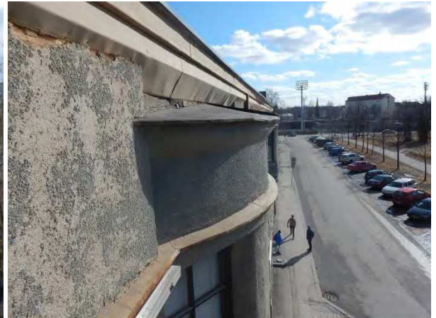
Kuva 3.43 Erkkerin kate, räystään verhouspelti ja vesilippa länsisivulla
