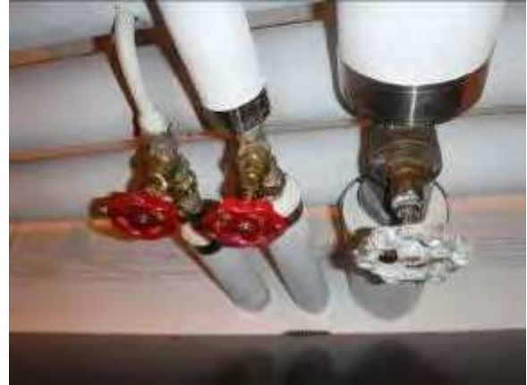
Linjaventtiilien toiminta on jo epävarmaa
