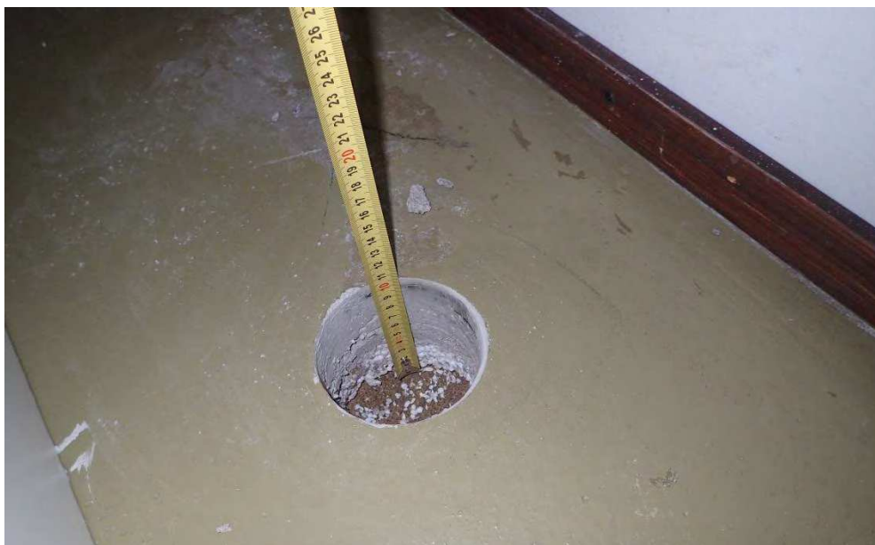
Kuva 2. Tilan 031 alapohjaan tehty rakenneavaus.
