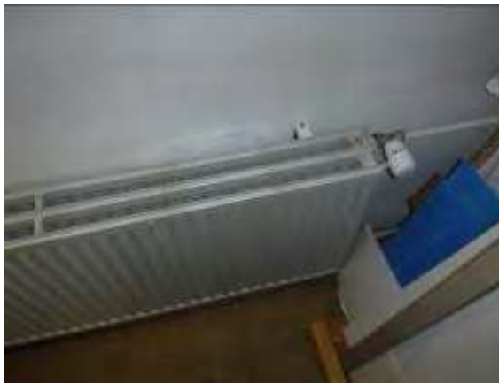
Patteriventtiilit ovat arviolta vuodelta 1995
