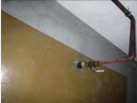
Tonttivesijohto on uusittu
