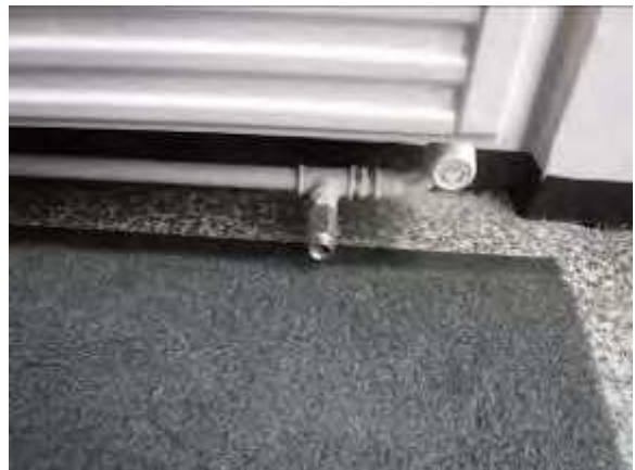
Verkon tyhjennyksen kuulasulkuun olisi hyvä lisätä tulppaus.
