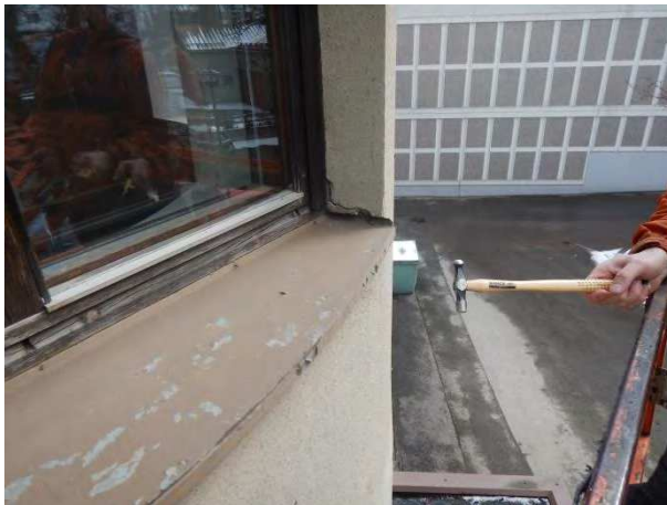
Kuva 3.36 Sisäänkäyntitornin ikkuna, etelä
