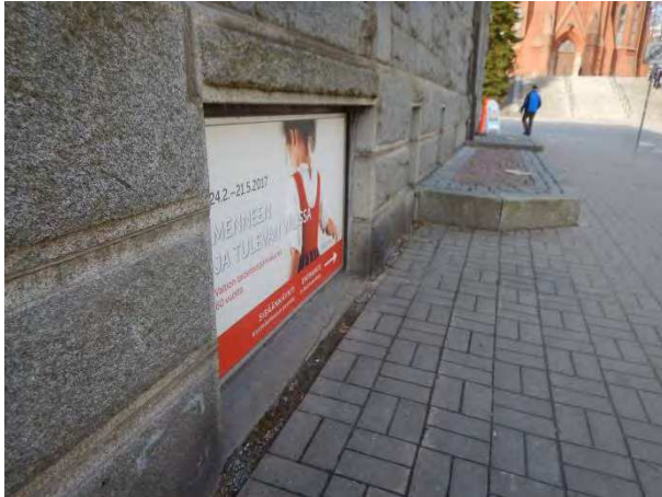
Kuva 3.30 Kellarin ikkuna lähellä maanpintaa ja alareunan kivi halki
