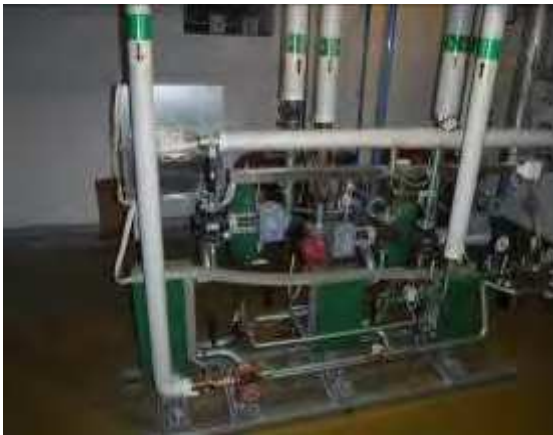
Lämmönsiirrinpaketti
