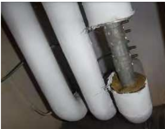
Eristeet sisältänevät asbestia.
