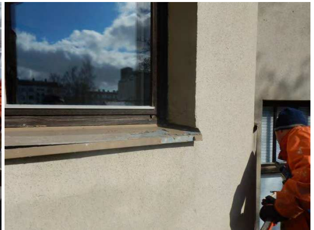
Kuva 3.37 Vesipelti repeytynyt
