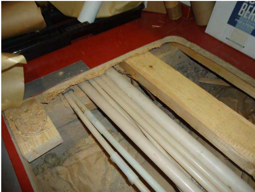
Kuva 9. Varaston 110 lattian rakenneavaus.
