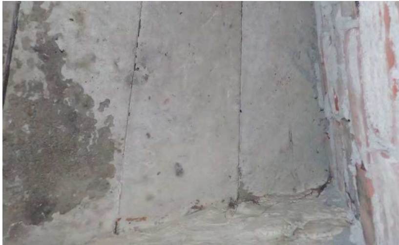
Kuva 16. C-portaan alustatilan kattoa.
