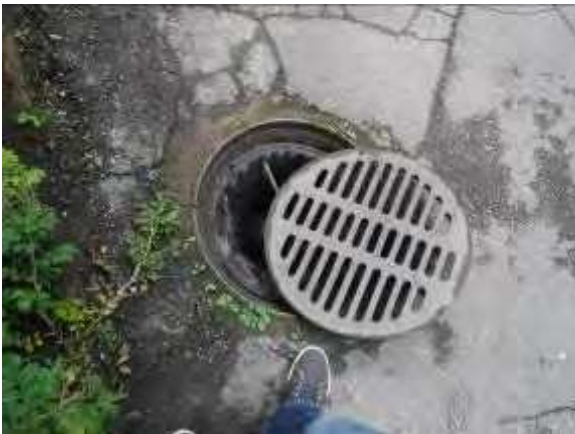
Sisäpihalla on yksi sadevesikaivo
