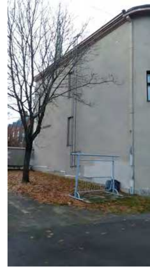
Puretun halkokellarin kohdalla sokkeli betonia ei graniittikivistä.
