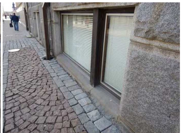
Kuva 3.39 Kellarin ikkuna pohjoispuolella
