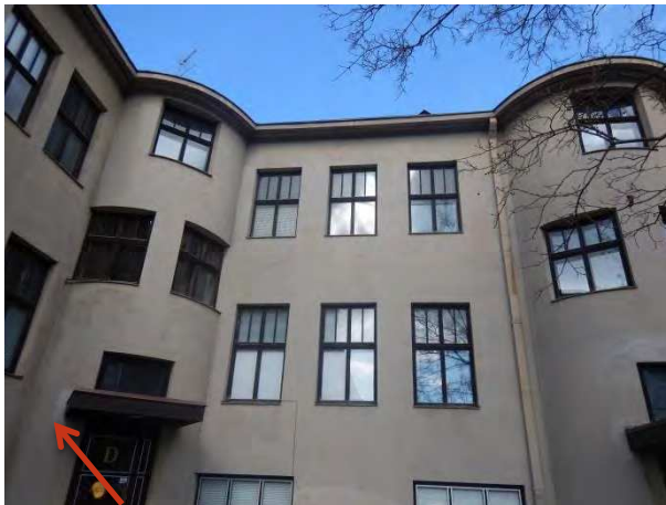
Kuva 3.8 Eteläjulkisivu sisäpihalla (D-porras)
