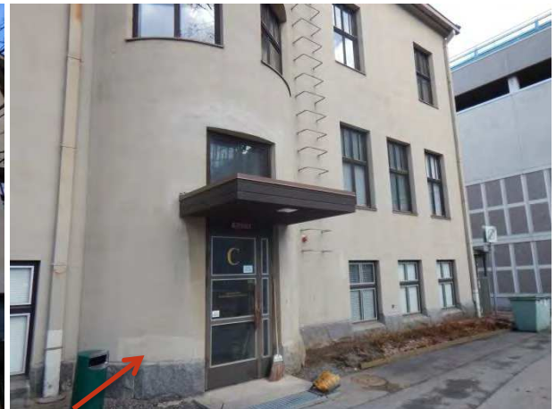
Kuva 3.9 Eteläjulkisivu sisäpihalla (C-porras)
