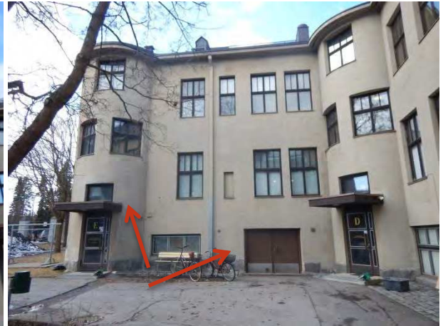
Kuva 3.7 Itäjulkisivun sisäpihalla (E- ja D-porras)
