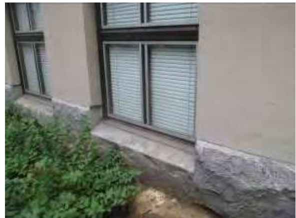
Ikkunarakenteet ovat pääosin 2- puitteisia puu/alumiini- ikkunoita.
