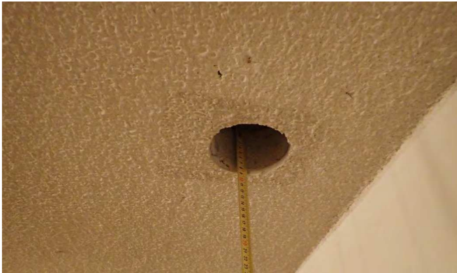
Kuva 6. Rakenneavaus tilan 031 kattoon (välipohjaan).
