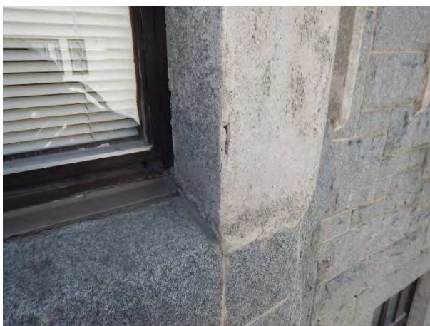
Kuva 3.38 Pohjoissivun erkkerin ikkuna
