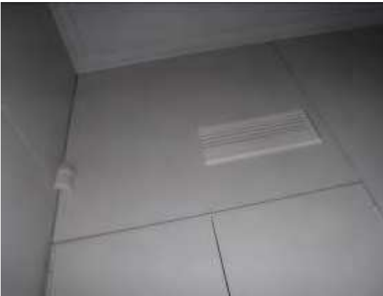
Yksittäisiä päätelaitteita oli uusittu
